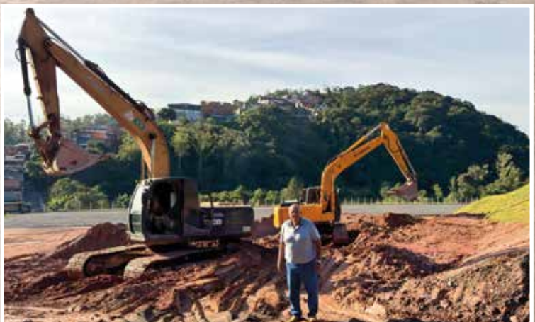
Reforma entrou na reta final, com conclusão prevista nos próximos meses
