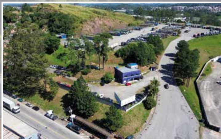
Foto aérea da entrada do pátio, que comportará entre 400 e 450 carretas
