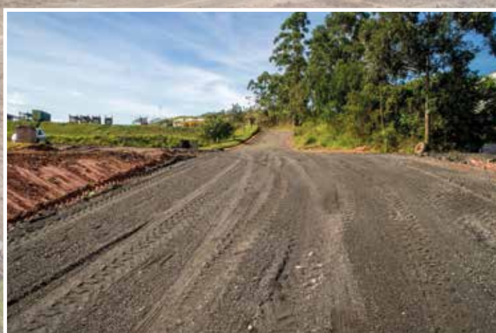
Rampa de acesso ao terceiro piso: aplicação de cascalho para evitar atolamento e melhorar a circulação
