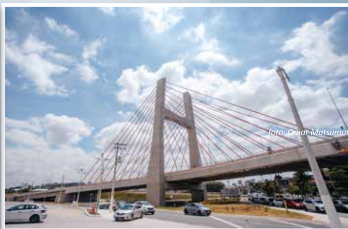
Inaugurada em dezembro, primeira Ponte Estaiada do município foi projetada para absorver aproximadamente 20 mil viagens por dia
