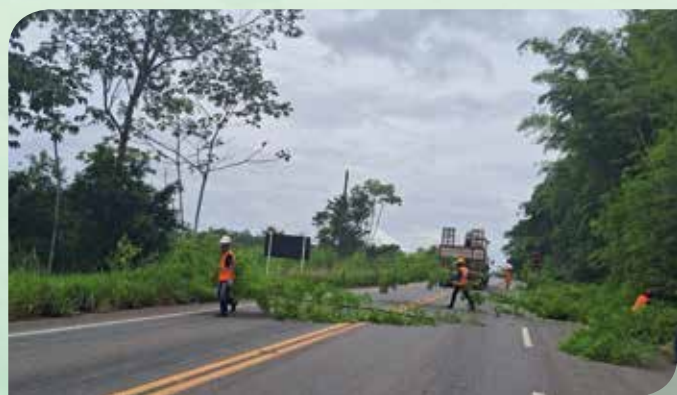
Equipe 3 executou podas na BA-093, no trecho entre Pojuca e Camaçari, na Bahia
