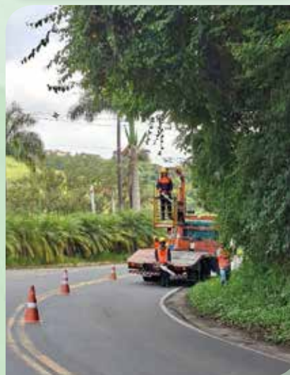
Equipe 2 trabalhou na MG-353, no trecho entre Coronel Pacheco e Juiz de Fora, em Minas Gerais
