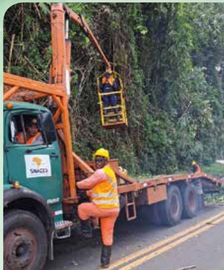
Equipe 2 trabalhou na BR-267, em trecho urbano de Juiz de Fora (MG)
