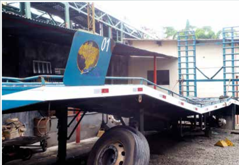
Plataforma antes da reforma
