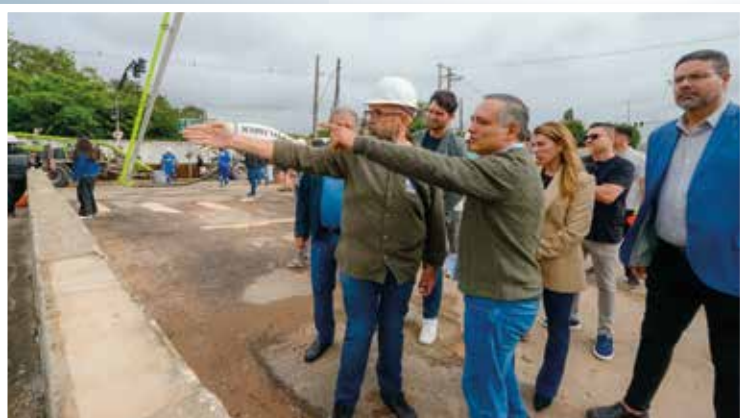
Prefeito Marcelo Lima acompanha o avanço das obras de viadutos no Corredor ABD
