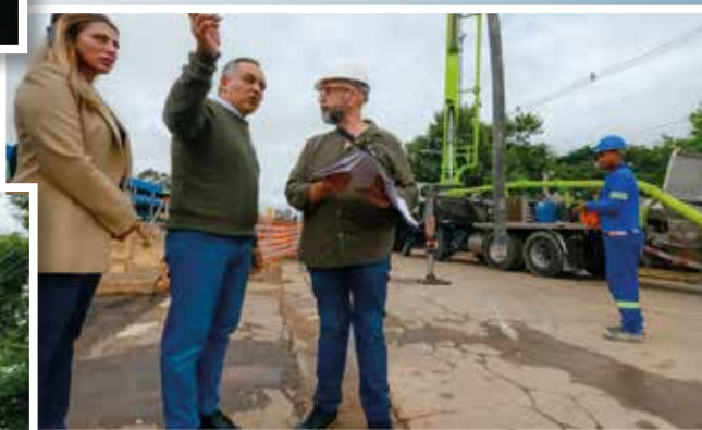
Equipes técnicas e autoridades discutem as próximas etapas da concretagem dos pilares
