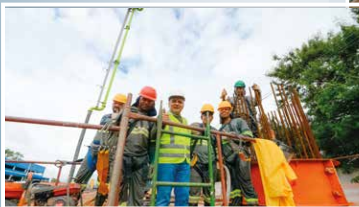
Trabalhadores e representantes da Prefeitura celebram o progresso da obra que deve melhorar a mobilidade em São Bernardo do Campo
