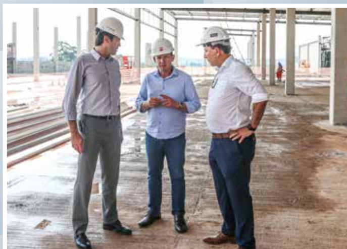
Vistoria nas obras do Outlet Premium Imigrantes, com previsão de abertura no primeiro trimestre
