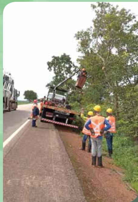
Equipe 1 trabalhou na BR-153, no trecho entre Aliança do Tocantins e Fátima, no Tocantins
